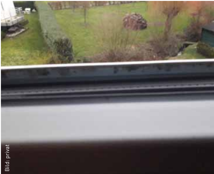
Verschmutzungsspuren im Anlagebereich der Glasdichtung.
