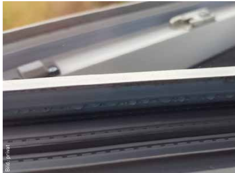
Feuchtigkeit zwischen Glas und Anlagebereich des Rahmens.
