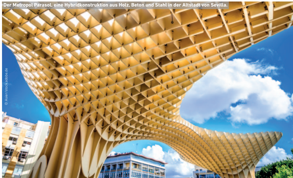
Der Metropol Parasol, eine Hybridkonstruktion aus Holz, Beton und Stahl in der Altstadt von Sevilla.
